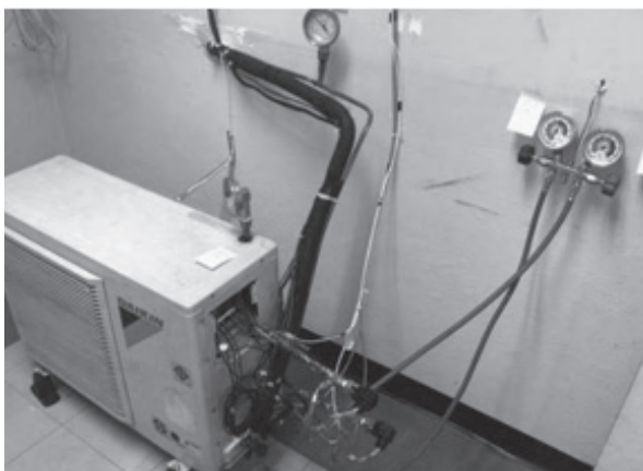
รูปที่ 16 : การติดตั้ง Sensor ด้าน Condensing unit
